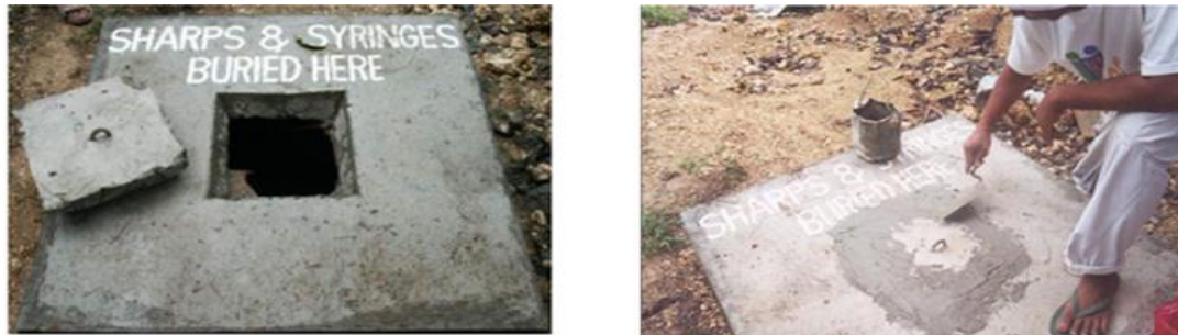
الصورة رقم ٩ : نموذج لحفرة طمر النفايات الخطرة
